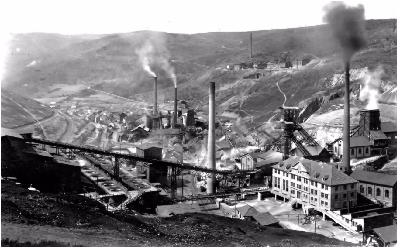
Bild 6: Grube Storch & Schöneberg, die metallischen Röstöfen im Bild unten links, 1925
