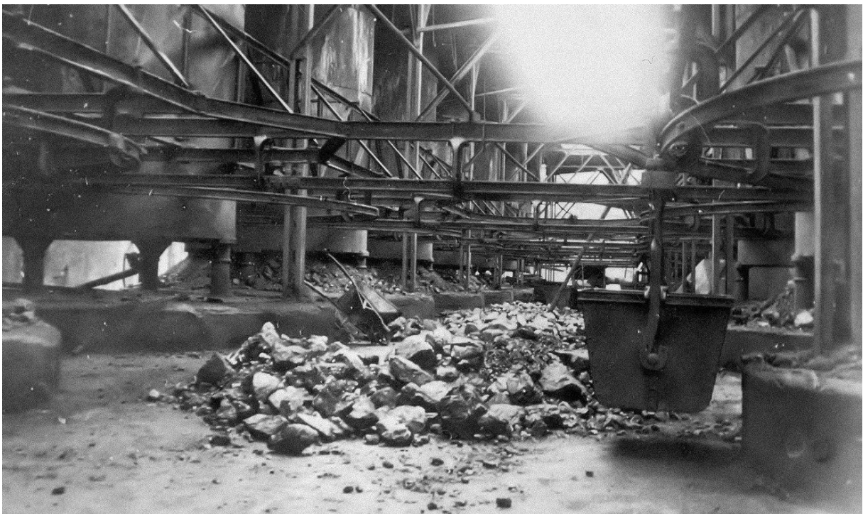
Bild 5: Grube Storch & Schöneberg, Röstöfen mit der Hängbahn
