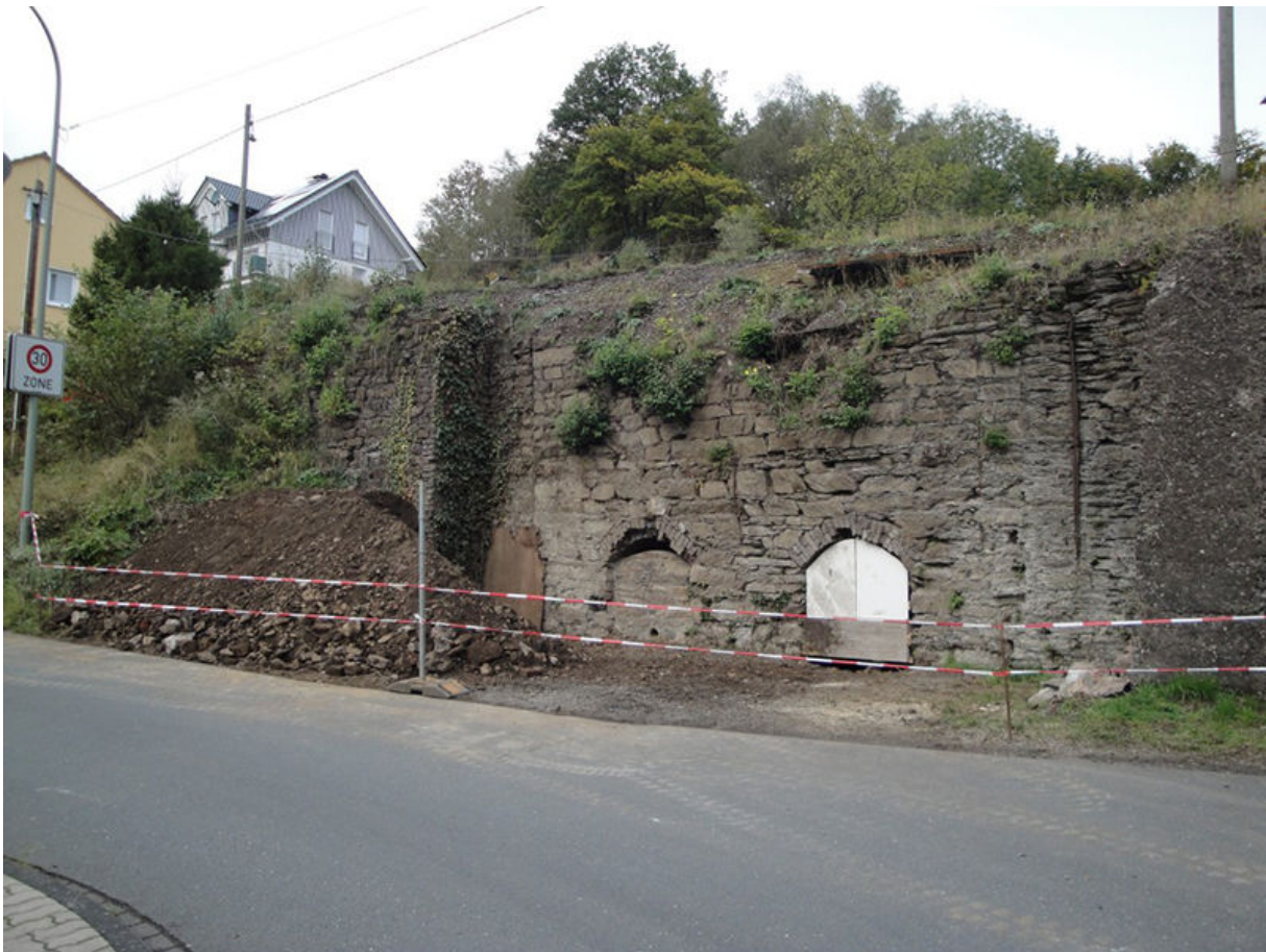
Bild 1: die „alten“ aus Bruchsteinen und Ziegelsteinen gemauerten Röstöfen
