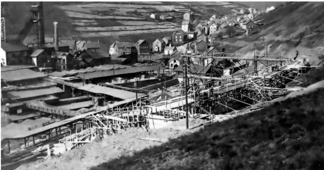
Bild 2: Grube Storch & Schöneberg, Bau der Aufbereitung, Anlage neue Röstöfen, kahle Hänge am Johannesberg
